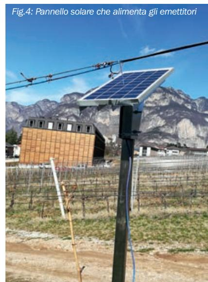
Fig.4: Pannello solare che alimenta gli emettitori
